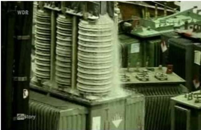
Aus Transformatoren entweichender PCB-Staub bei Envio
